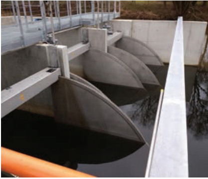
图 3. 曝气通道出口处的可调出水堰。
